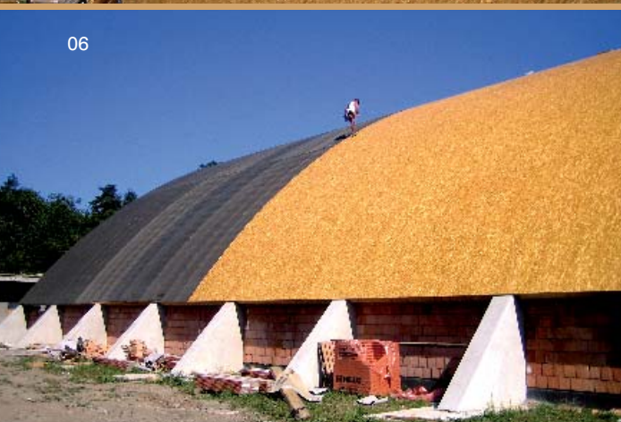
04-05 | Nosná konstrukce střechy, základ z OSB desek 06 | Kotvení parozábrany z asfaltového pásu DEKGLASS G200 S40
