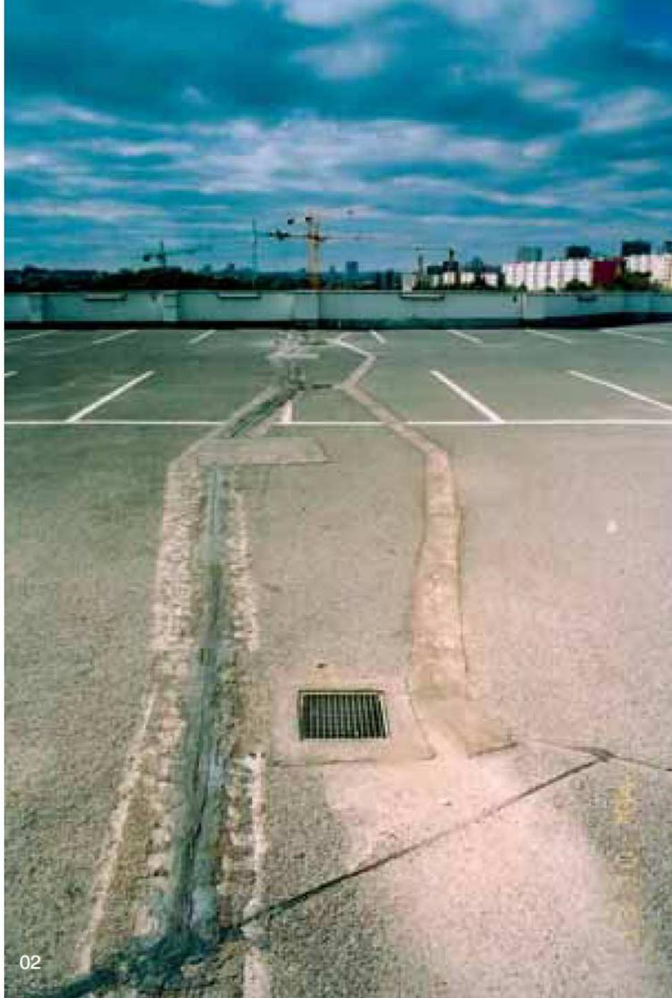
V oblasti dilatace docházelo k dlouhodobým průsakům srážkové vody do podstřeší. Prosakující voda byla provizorně jímána do žlabů umístěných pod kritická místa a řízeně z prostoru odváděna. Průsaky se nepodařilo odstranit ani několikaletými opravami kritických míst pojízdné střechy /obr. 02/. Nezbylo, než se problémem podrobněji zabývat.
