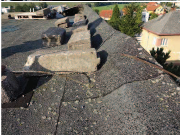
09| Havárie strechy s hydroizoláci z asfaltových pásů.
