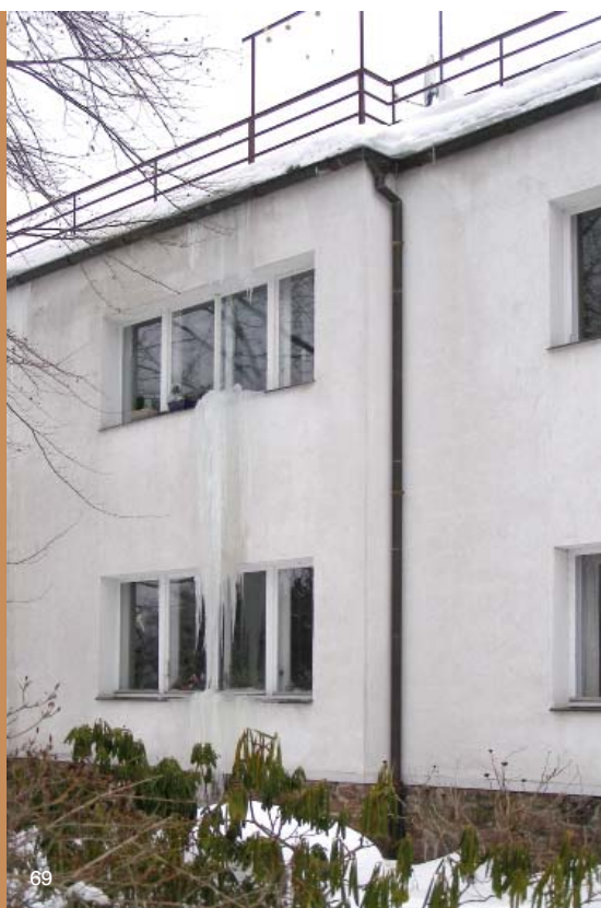
69| Podkrkonoší, Nová Paka – namáhání navazujících a chráněných konstrukcí (fasáda, parapety, výplně otvorů) vodou přetékající i vnitřní hranu zaledněného žlabu
