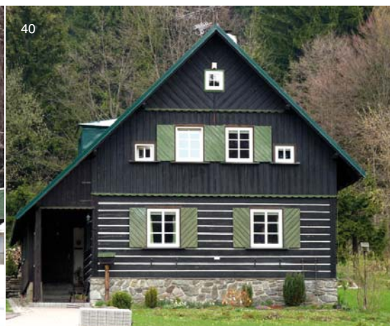
40| Čelní pohled na objekt z předchozí fotografie. Nad vchodem chráněným přesahem střechy nehrozí pád sněhu na osoby
