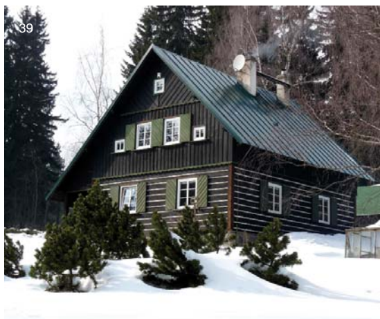
39| Krkonoše – typická horská chalupa, která respektuje klimatické podmínky v místě stavby (jednoduchý tvar střechy – malé množství prostupů umístěných blízko hřebene střechy – velký sklon střechy v kombinaci s hladkou krytinou bez sněhových zachytávačů, na které se nehromadí sníh – absence podokapních žlabů a dostatečný akumulací prostor pod okapní hranou pro hromadění sněhu)
