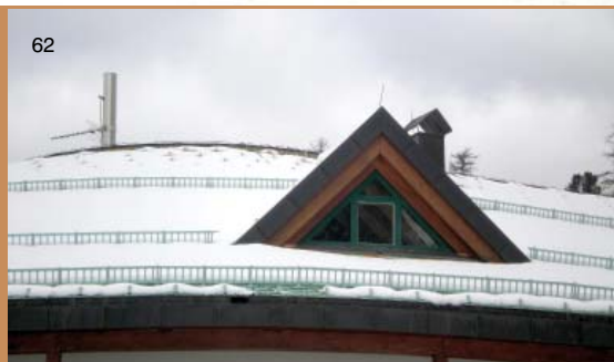
61, 62 | Alpy – příklady rozmístění sněhových zachytávačů. Zachytávače mohou zmenšit uvolněné množství sněhu/ledu a snížit tak statické i dynamické namáhání podokapních žlabů a žlabových háků. Zachytávače umístěny na rozhraní teplé a studené zóny střechy, dále pak v ploše střechy
