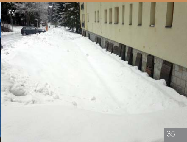
77| Snaha o prevenci ochrany navazující konstrukce použitím voděodolného materiálu (kamenné zdivo). Rozhraní mezi kamenným zdivem a fasádním systémem je nízké. Úroveň akumulovaného sněhu/ledu bývá vyšší a dochází k poškození fasádního systému
