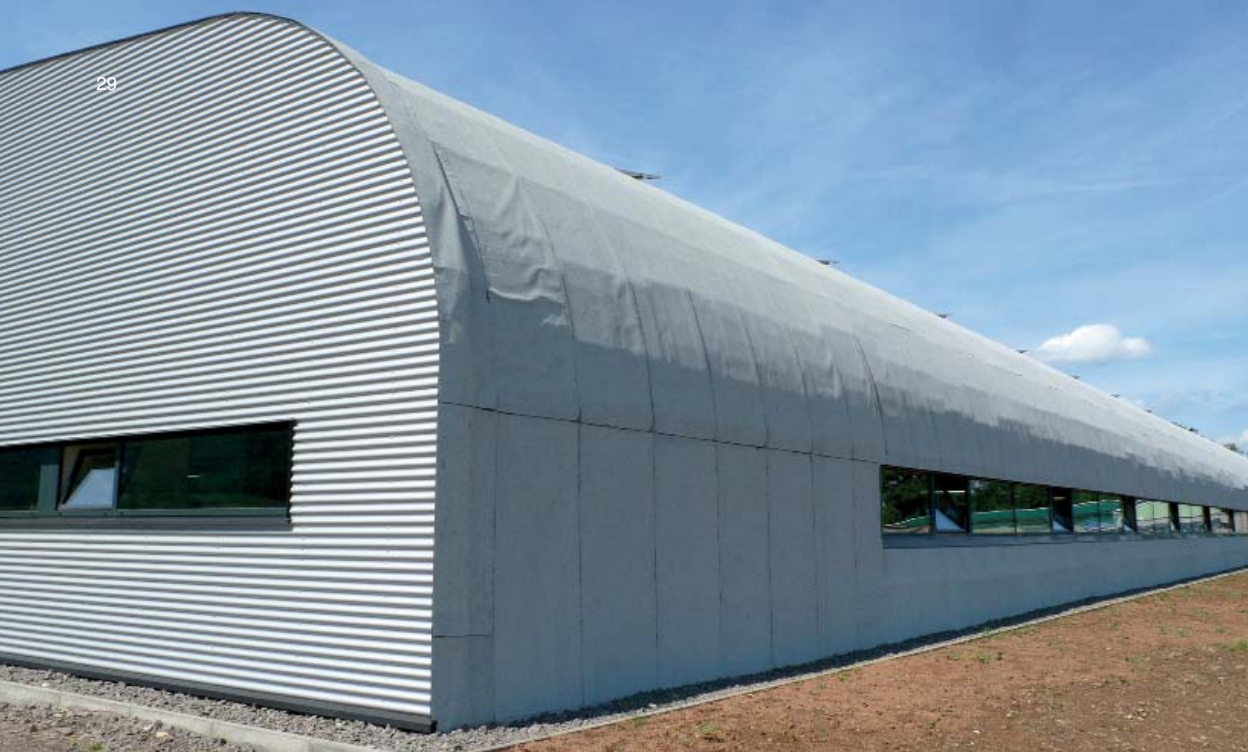
29| Odvážné řešení odvodnění střechy odkapem vody z okapního plechu nad pásovými okny. Správná volba tvaru parapetů (strmý sklon) i povrchu chráněných konstrukcí (povlaková hydroizolace). Rizikové řešení závislé na chování uživatele objektu (otevírání/zavírání oken)
