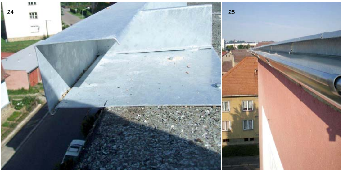
24, 25 | Záběry z realizace detailu z /obr. 23/
