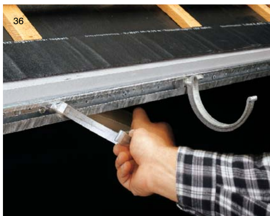
36, 37| Příklady řešení umožňujícího dočasné snímání žlabu i háků [1]
