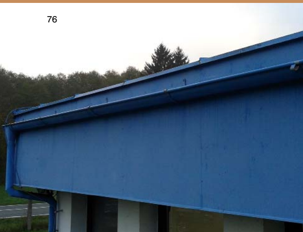
76| Orlickoústecko – eliminace poškození navazující konstrukce vytvořením její voděodolné povrchové úpravy (plech)
