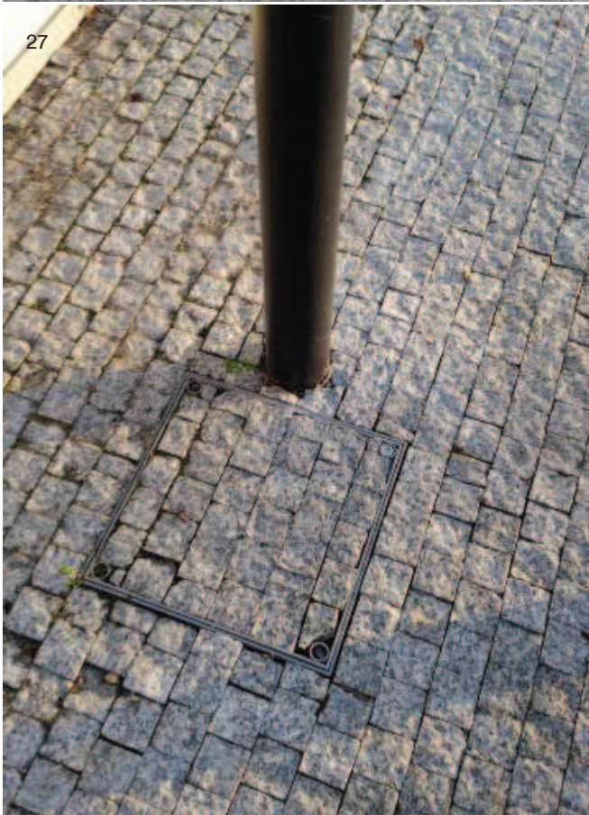
23, 24 | Realizace provozní vrstvy z žulových kostek do podsypu.
