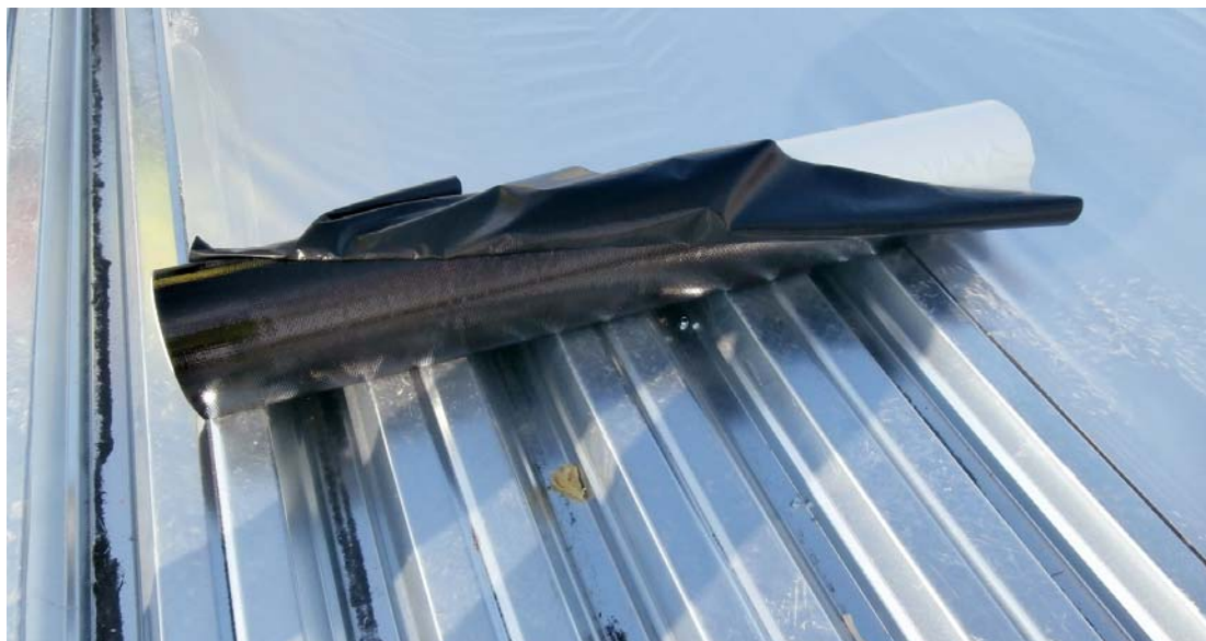
08 | Realizace parozábrany ze samolepicího SBS pásu
