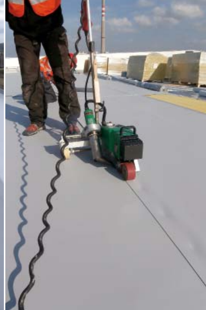
12| Svařování hydroizolační vrstvy DEKPLAN 76 svařovacím automatem
