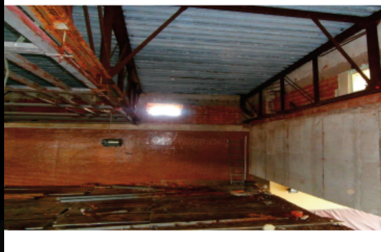
Pohled na zdegradovanou konstrukci vazníků, pád při opravách
