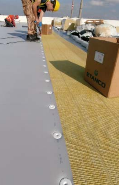
10| Kótvení hydroizolační vrstvy DEKPLAN 76
