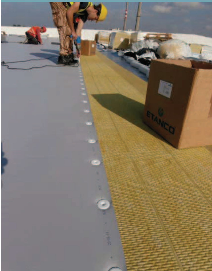
03 | Kotvení hydroizolační vrstvy DEKPLAN 76
