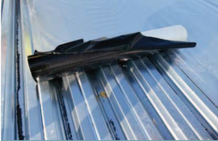
01 | Realizace parozábrany ze samolepícího SBS pásu
