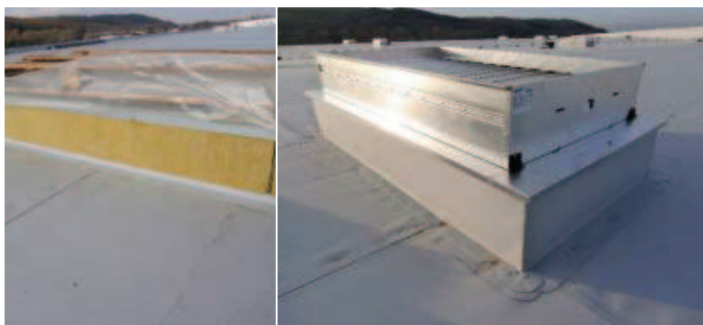
06 | Ukončení hydroizolace na ventilátoru s ukázkou jeho finální podoby na střeše
