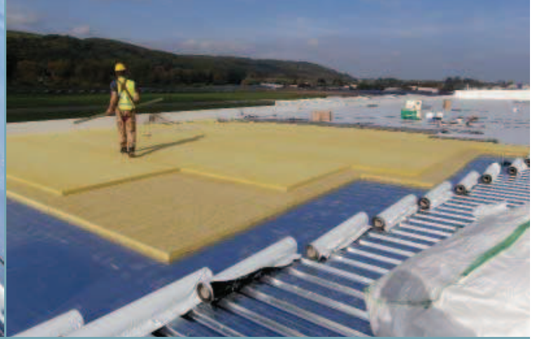
02 | Etapové provádění střešní skladby DACO KSD-R s nízkou požární zátěží
