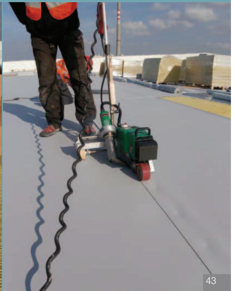
04 | Svařování hydroizolační vrstvy DEKPLAN 76 svařovacím automatem
