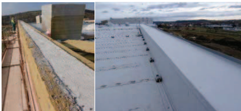
07 | Ukončení hydroizolace na štítové stěně s ukázkou její finální podoby na střeše
