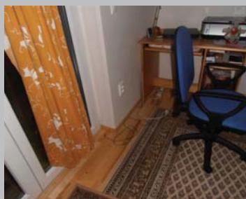
01 | Pohled na netěsné elektrorozvody
