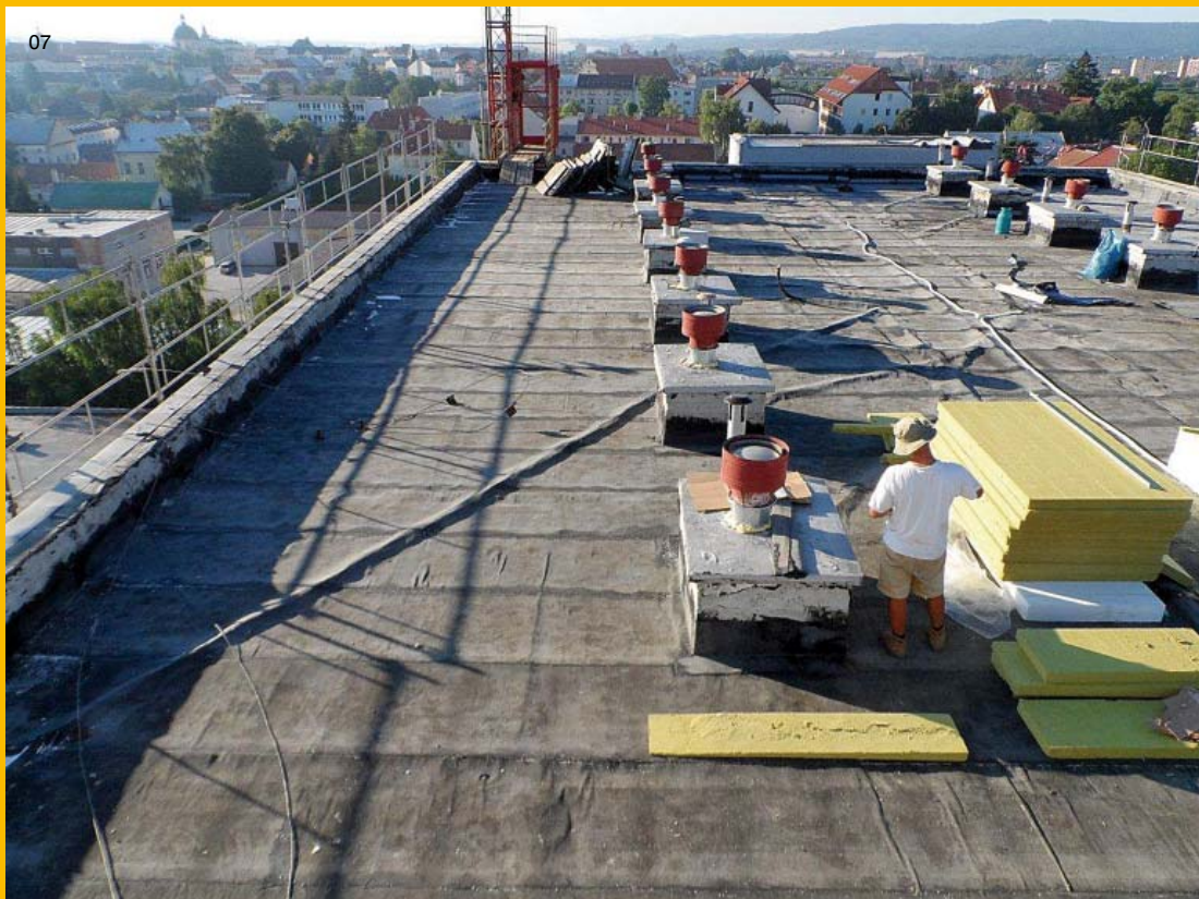
07 | Nerovný podklad s natavenou parozábranou a provizorní hydroizolací z SBS modifikovaného asfaltového pásu
