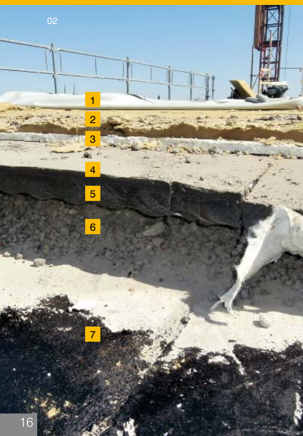
02 | Pohled do původní skladby střechy, popis skladby v Tabulce /02/
