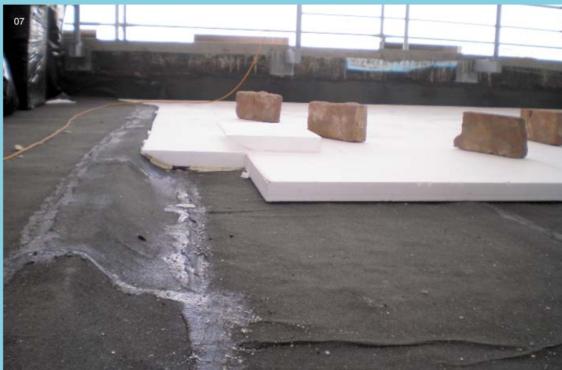
08 | Vytvoření úžlabí ve spádových klínech
