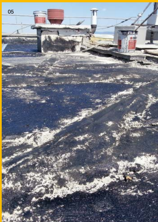
05, 06 | Na ŽB nosném panelu rozvody elektrických kabelů chráněné „hrobečky“
