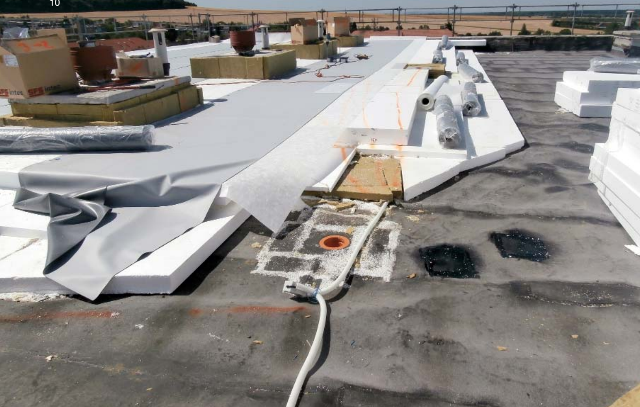
10| Překreslování polohy kabelů na pokládané vrstvy kvůli kotvení povlakové hydroizolace
