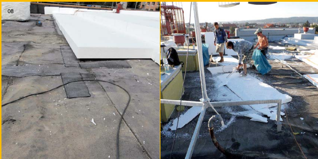
08, 09 | Vyrovnávání podkladu upravovanými deskami z EPS 100S
