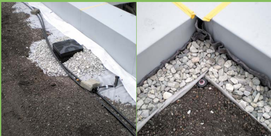
12, 13 | Do vrstvy substrátu zabudován rozvod závlahy. Fólie na koruně atiky montážně přichycena páskou.
