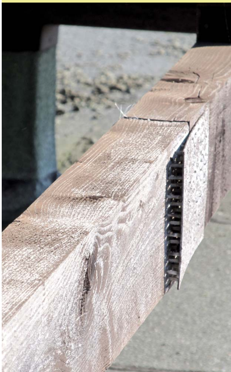
12 | Seschnutí dřeva způsobilo vytrhnutí kovové spojovací desky s prolisovanými trny
