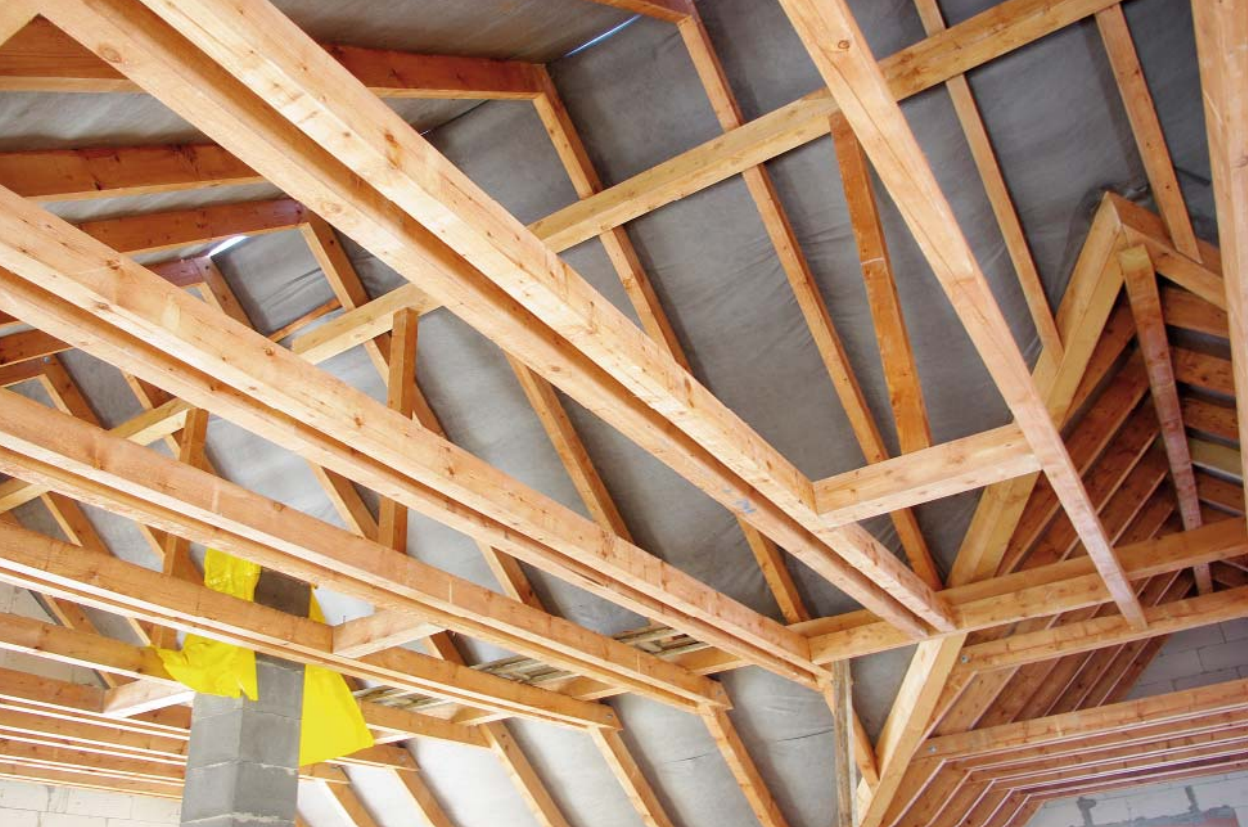
16| Vystavěný krov v objektu, kde nebyly vyzděny vnitřní stěny (patrně z vrcholové vaznice boční střechy)
