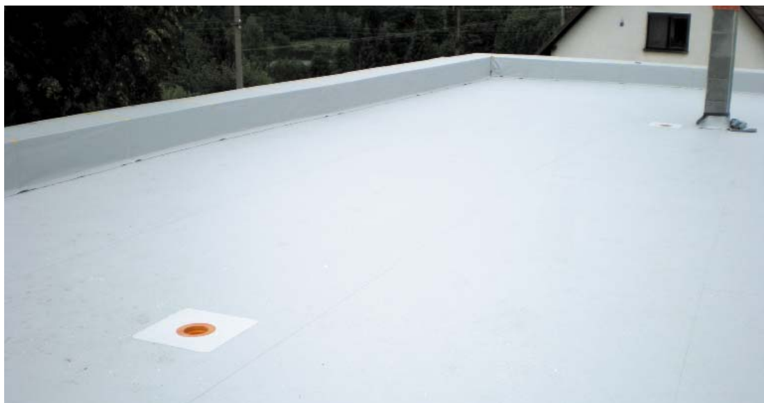
05_06 | Střecha po položení vrstvy tepelné izolace a hydroizolační konstrukce z fólie DEKPLAN 77
